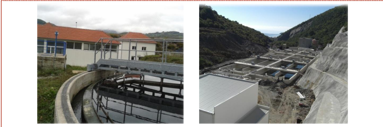
Abbildung 5.24: Kläranlage Mjkovac (links) und Kläranlage Budva (rechts) Quelle: godina, Stand 02/2018 [87]
