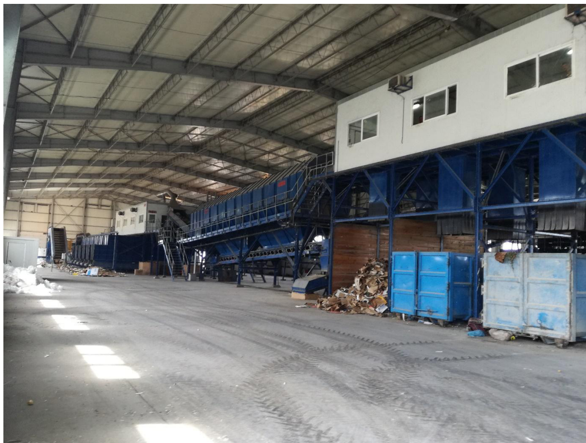
Abbildung 4.16: Sortieranlage für Siedlungsabfälle, Podgorica, Juli 2017
