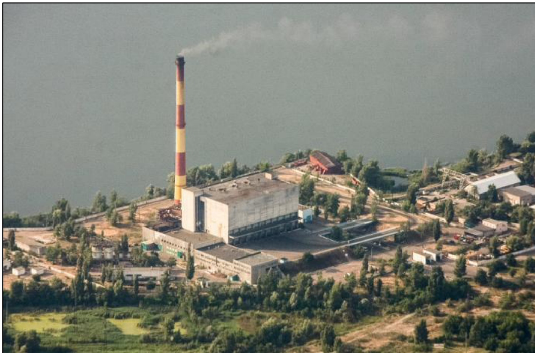
Abbildung 4.12: Enerhiia Müllverbrennungsanlage in Kiew
